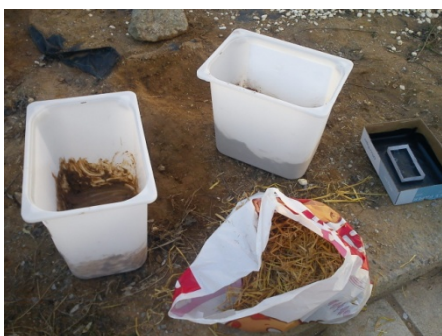
Σχήμα 10 : Η διαδικασία κατασκευής των καλούπιών για τους πλίνθινους τοίχους
