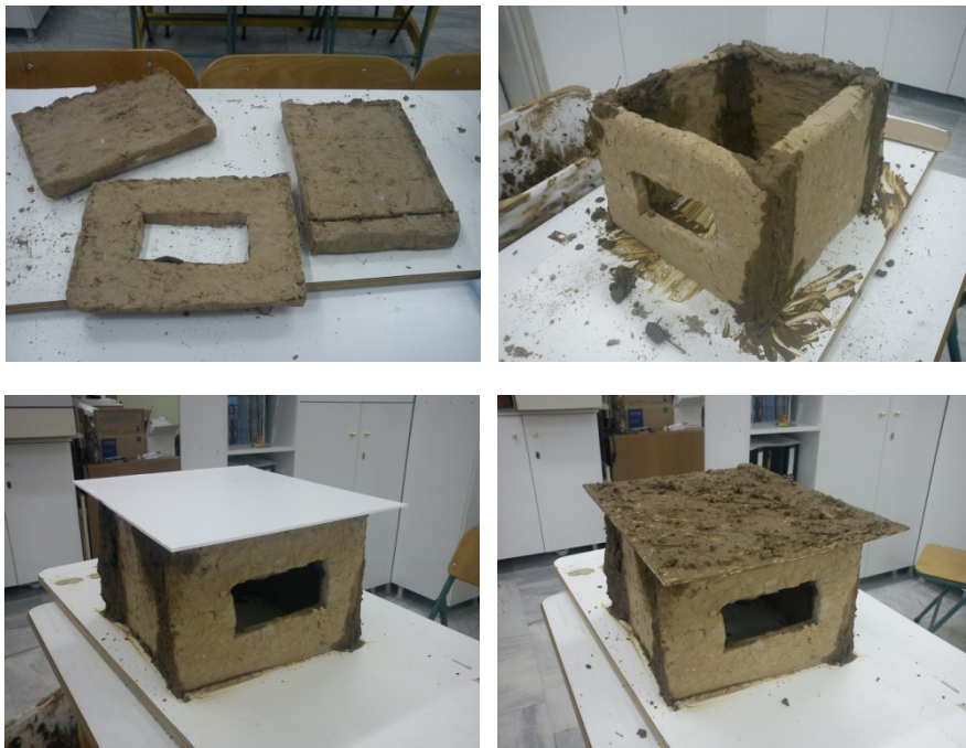
Σχήμα 11 : Στάδια κατασκευής του πλίθινου σπιτιού
